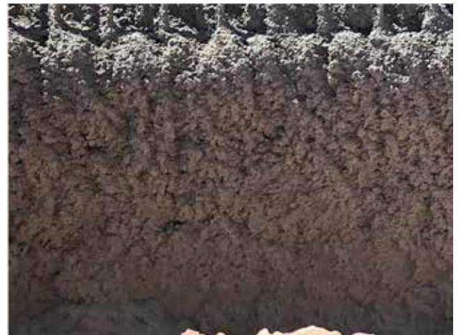
Fig. 8: Ondulación superficial por ángulo incorrecto
