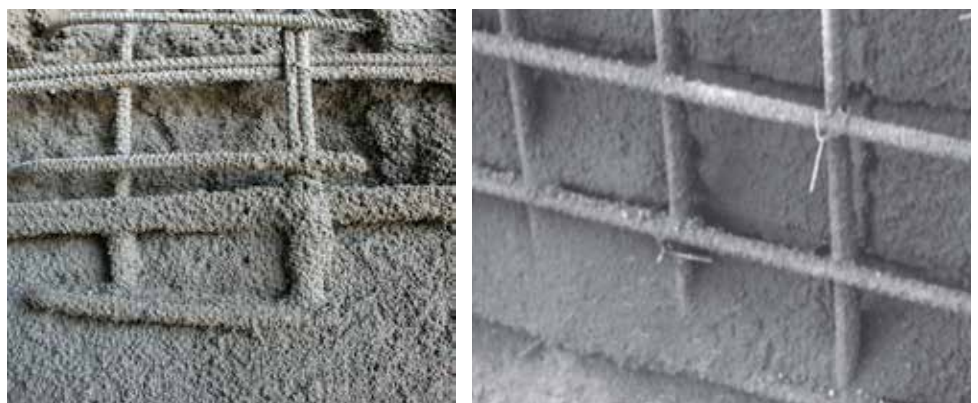
Fig. 6: Superficie arenosa u opaca durante la aplicación
