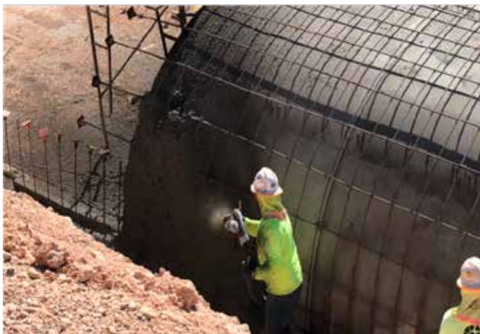
Fig. 8: Ondulación superficial por ángulo incorrecto
