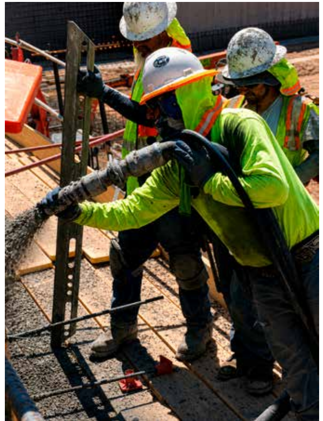
Fig. 3: Lanzador utilizando una postura adecuada para la colocación de concreto lanzado.
