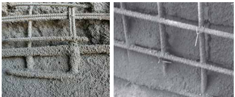
Fig. 6: Superficie arenosa u opaca durante la aplicación
