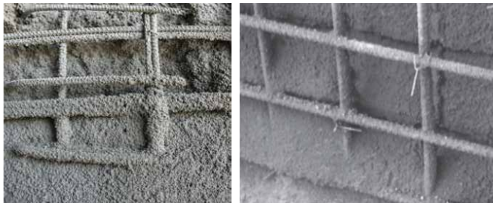
Fig. 6: Superficie arenosa u opaca durante la aplicación
