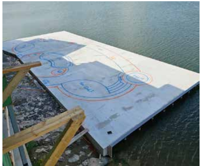
Trazo de la alberca sobre la losa de concreto suspendida sobre el agua
