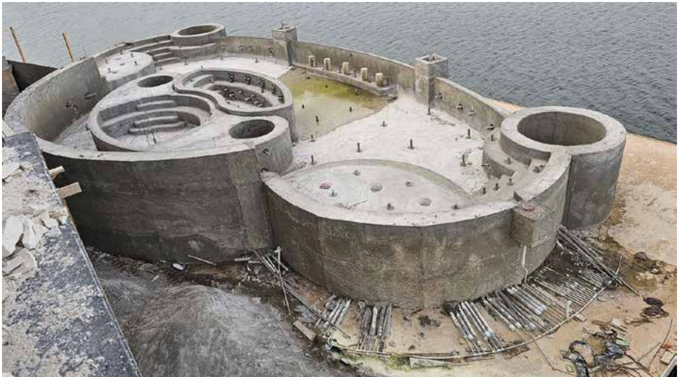
Colocación de concreto lanzado por vía seca terminada
