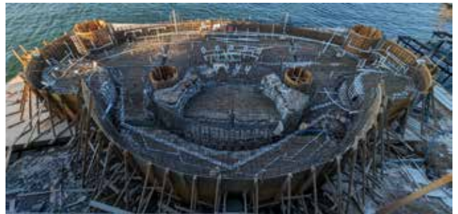
Alberca cimbrada con acero de refuerzo e instalaciones hidráulicas
