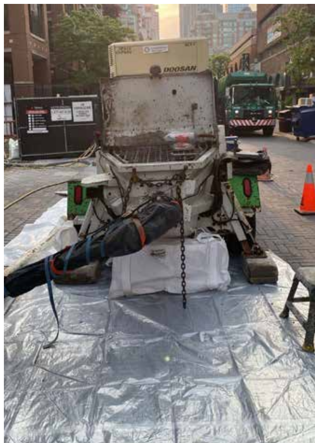
Fig. 5: La instalación de una cubierta «Python» confinará el hormigón dentro de la cubierta en caso de rotura.
