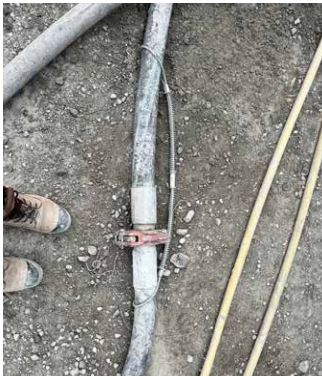
Fig. 1 y 2: Comprobaciones de latigazos instaladas en el material y las líneas aéreas para sujetarlas en caso de desconexión.
