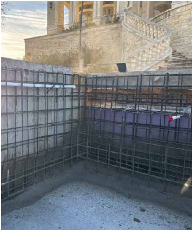
Fig. 4: Capa de concreto lanzado colocada sobre el piso colado.
