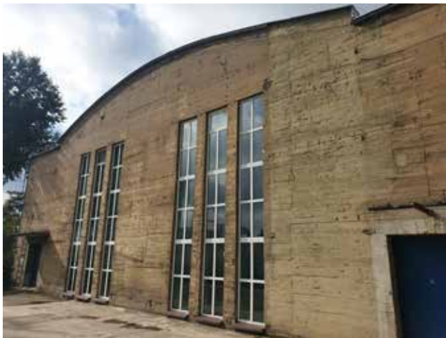
Elewacja budynku Filtrów Pospiesznych przed remontem
