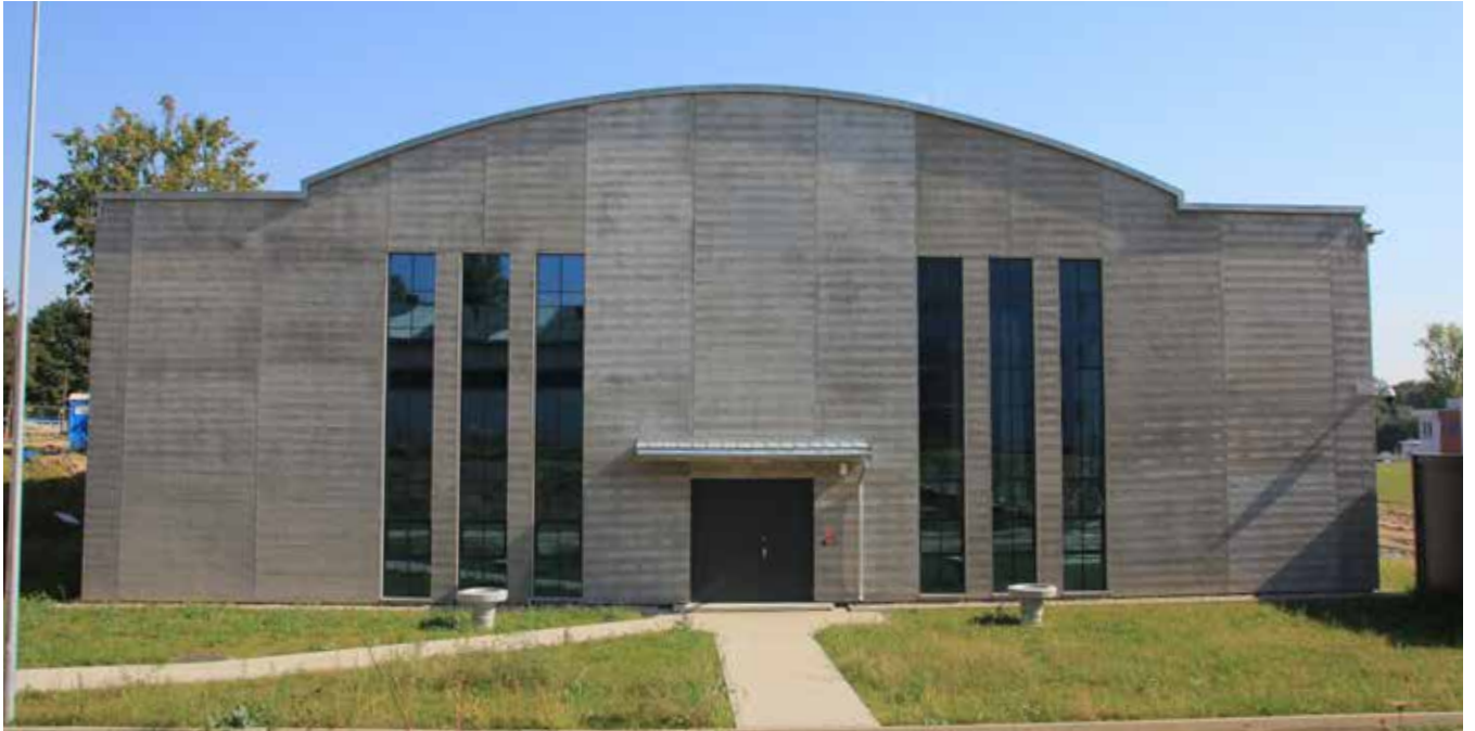
Elewacja po zakończeniu prac
