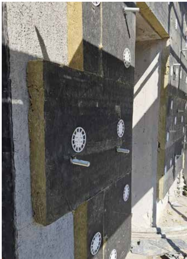
Osadzenie kotew i montaż ocieplenia budynku
