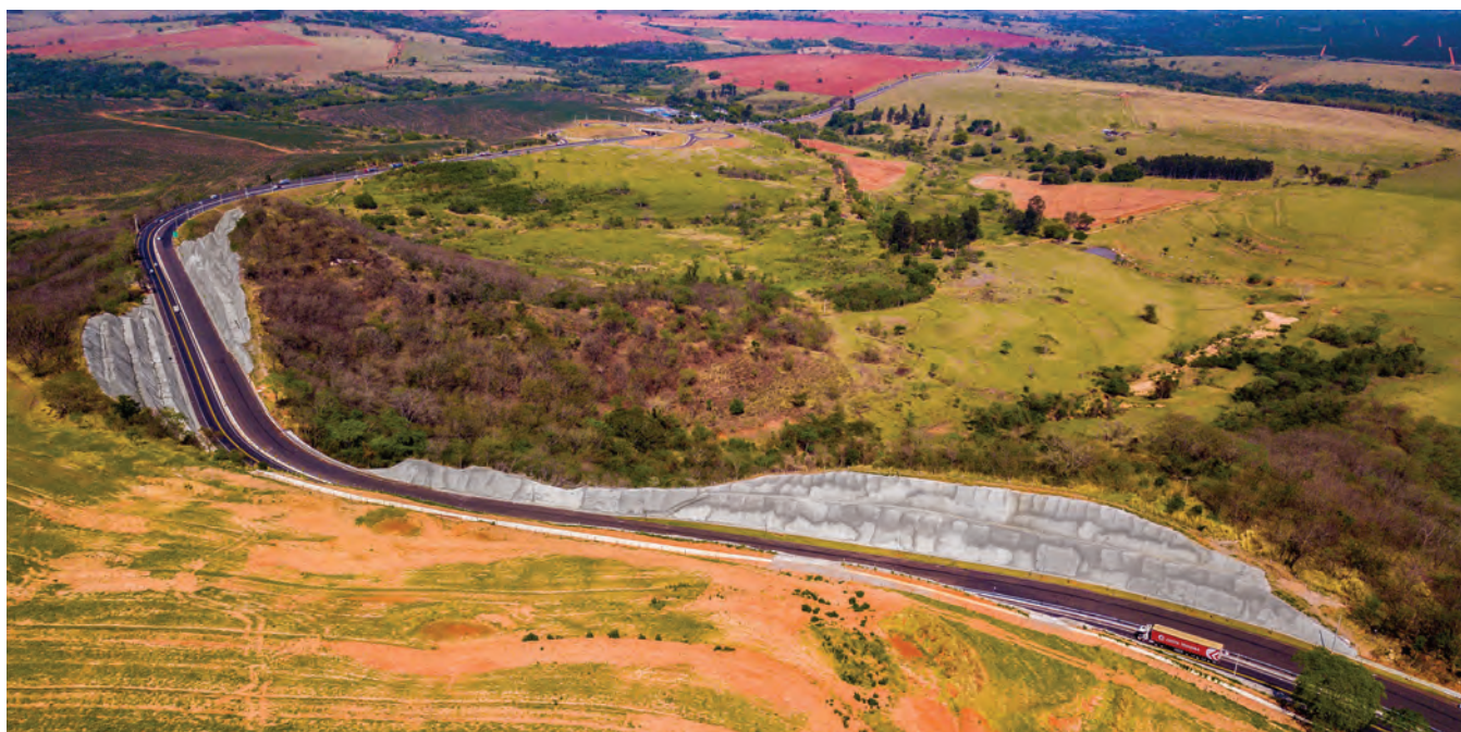
Fig. 1: Taludes rodoviários concluídos entre as cidade de Marília e Assis, no estado de São Paulo, Brasil.
