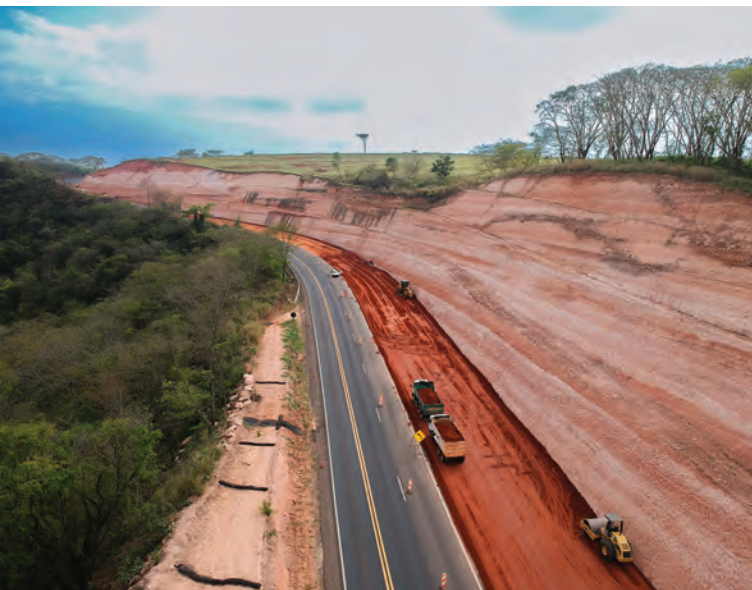
Fig. 3: Processo de escavação e retaludamento para ampliação da rodovia.
