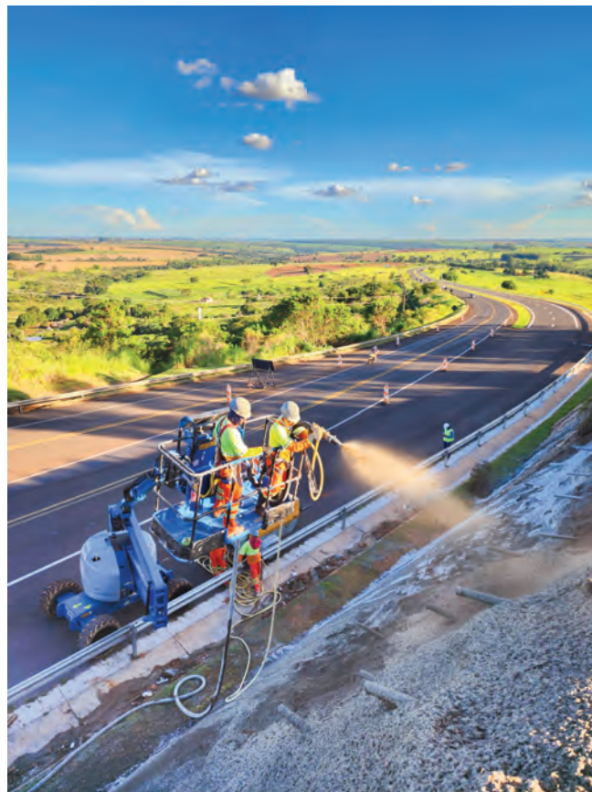
Fig. 8: Aplicação de concreto projetado com plataforma articulada.
