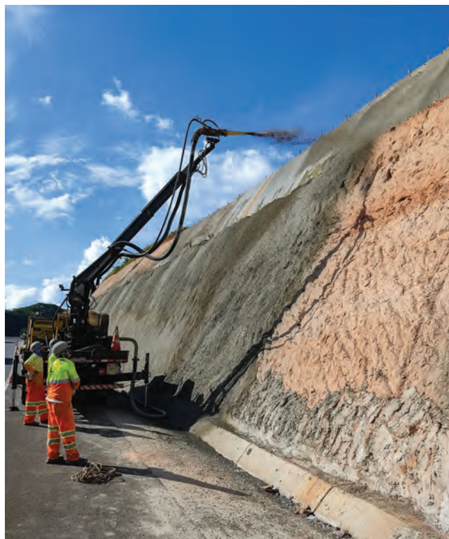
Fig. 6: Aplicação de concreto projetado usando um robô de projeção.
