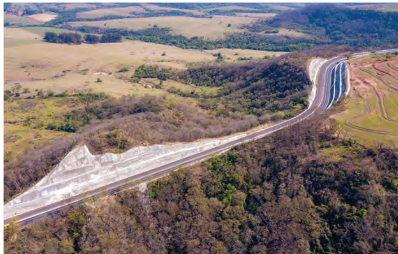
Fig. 12: Vista aérea do talude concluído.
