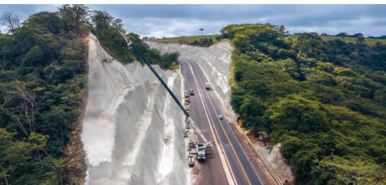
Fig. 5: Aplicação de concreto projetado com guindaste.
