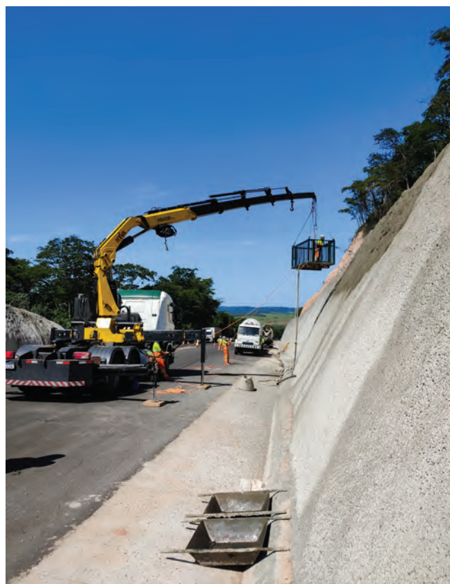
Fig. 9: Aplicação de concreto projetado com caminhão Munk.
