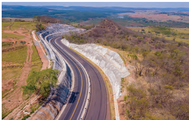
Fig. 13: Outra vista aérea do talude concluído.
