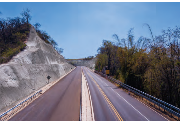
Fig. 11: Outra vista do talude após a aplicação do concreto projetado.
