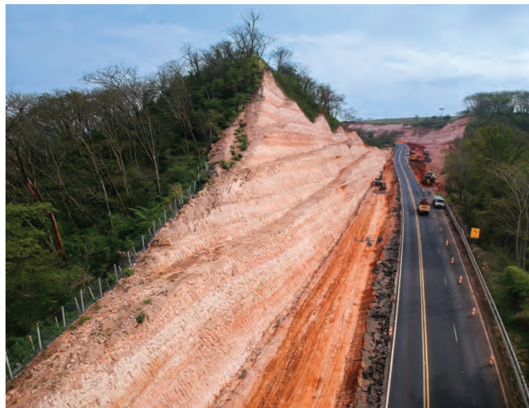
Fig. 4: Processo de escavação e retaludamento por outra perspectiva.
