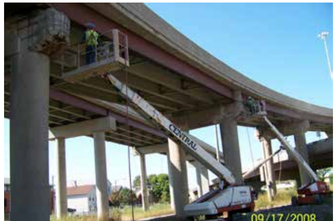
Fig. 2: Las plataformas elevadoras permiten un acceso rápido y conveniente a espacios de difícil alcance.
