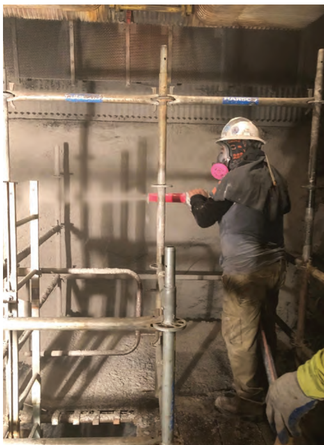
Fig. 1: Boquilla colocando refractario
