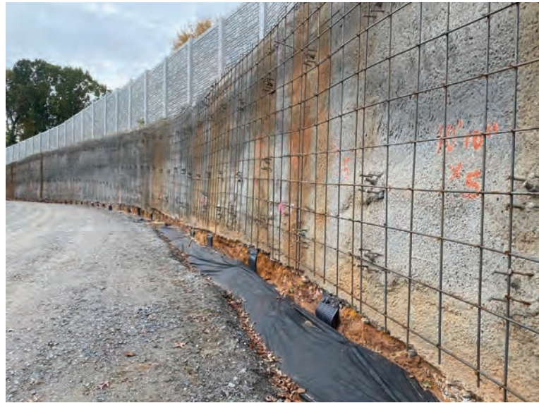
Una vez construida la pared de la uña del suelo, varias capas de excreta fueron colocadas delante de ella antes de tallar el acabado del ashlar en la capa final de dos pulgadas.
