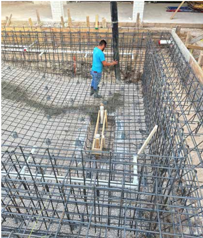
Fig. 2: Colocación de concreto en el piso de una alberca con bomba pluma.
