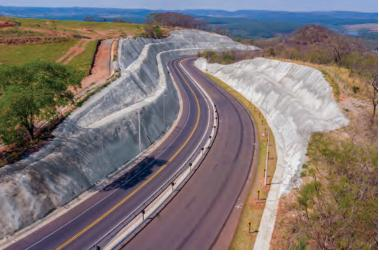
Fig. 10: Inclinação após aplicação de concreto projetado.
