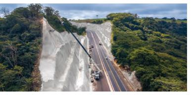
Fig. 5: Aplicação de concreto projetado com guindaste.
