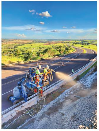
Fig. 8: Aplicação de concreto projetado com plataforma articulada.
