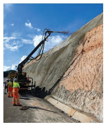
Fig. 6: Aplicação de concreto projetado usando um robô de projeção.
