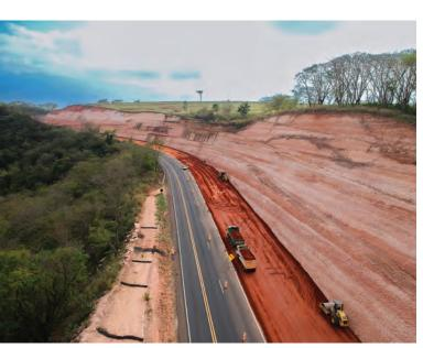
Fig. 3: Processo de escavação e retaludamento para ampliação da rodovia.
