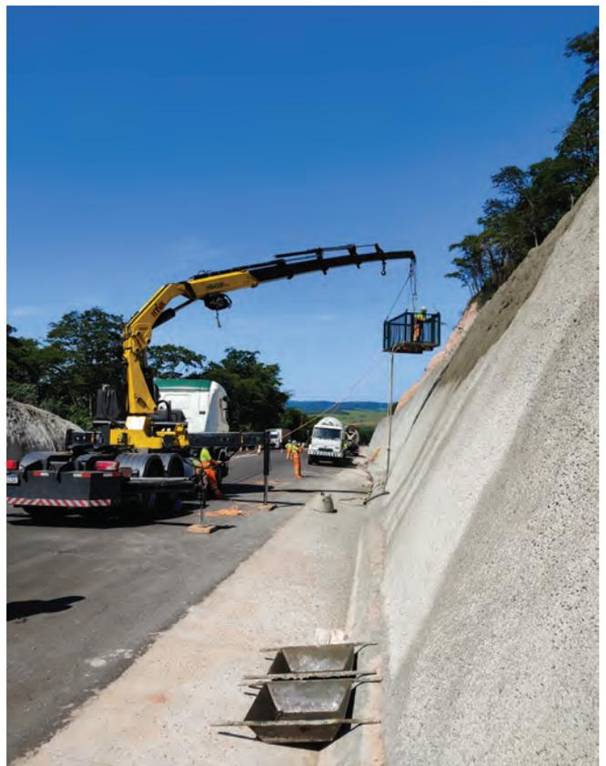
Fig. 9: Aplicação de concreto projetado com caminhão Munck.
