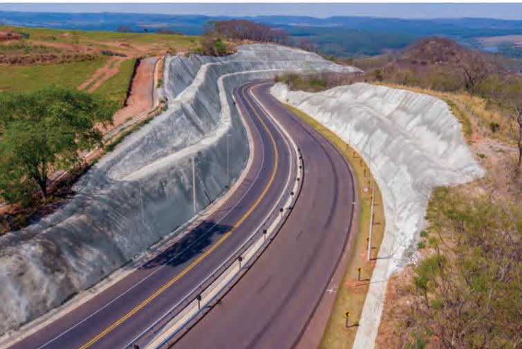
Fig. 10: Inclinção após aplicação de concreto projetado.
