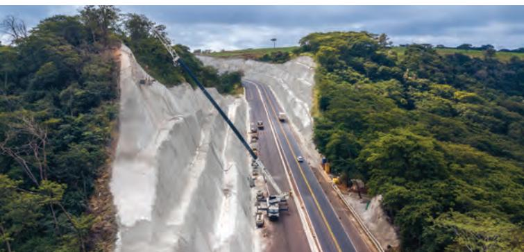
Fig. 5: Aplicação de concreto projetado com guindaste.
