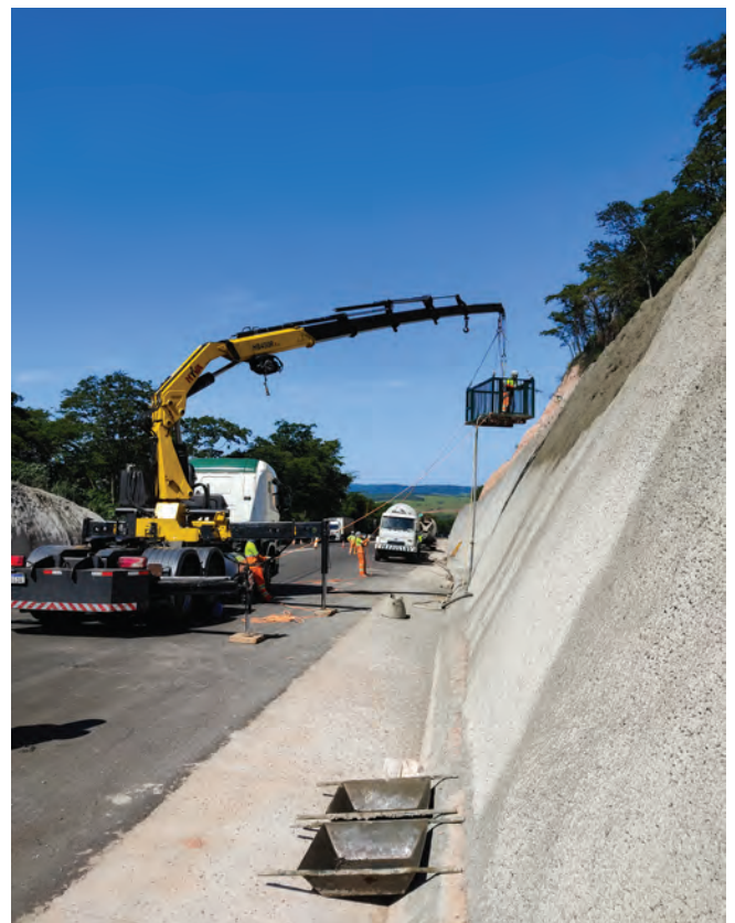
Fig. 9: Aplicação de concreto projetado com caminhão Munk.
