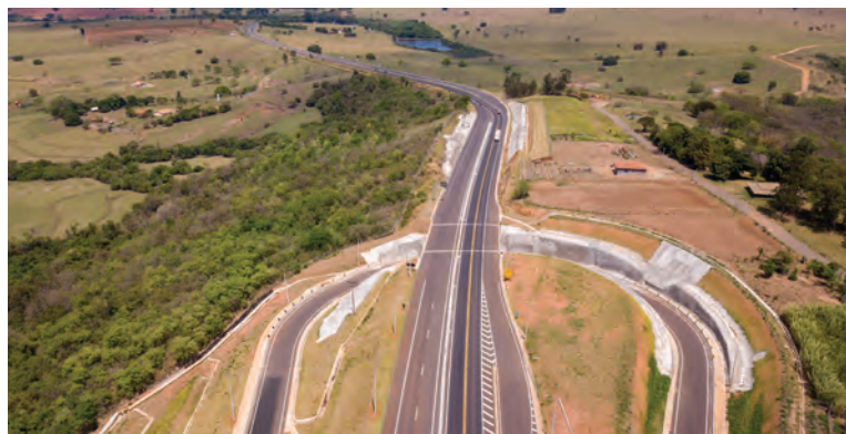
Fig. 2: Vista aérea dos taludes rodoviários.
