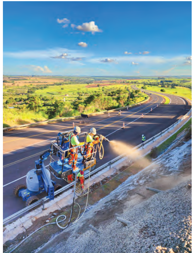
Fig. 8: Aplicação de concreto projetado com plataforma articulada.
