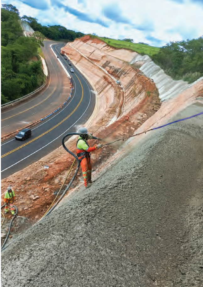
Fig. 7: Aplicação de concreto projetado pela técnica de rapel.
