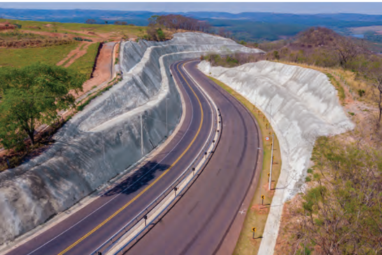
Fig. 10: Inclinção após aplicação de concreto projetado.
