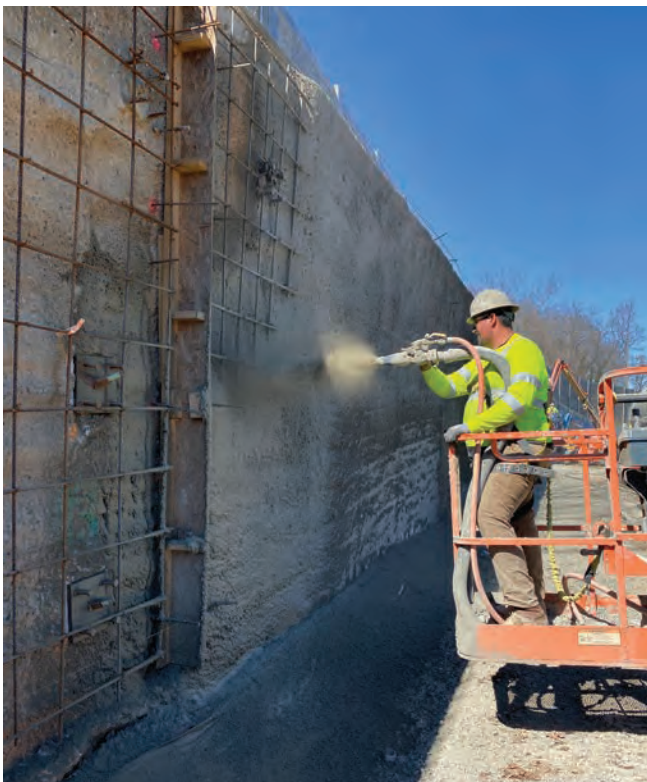
Los nozzlemen de escopeta trabajaban principalmente desde los levantamientos, disparando hasta 70 yardas cúbicas de material en un solo día.
