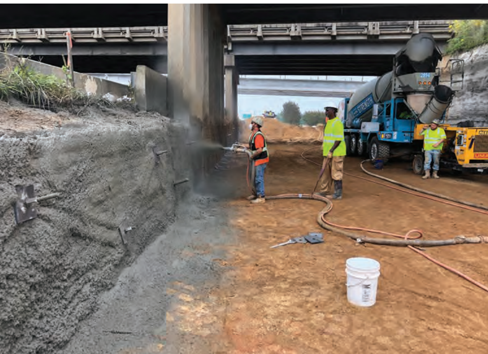
La retención de la tierra de UMA y el trabajo esculpido de la escopeta en el proyecto de mejoras de intercambio I-40/I-77 de NCDOT mantuvieron los cortes para tramos de carreteras más ampliados y facilitaron la construcción de nuevos puentes.
