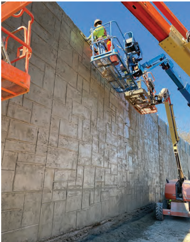
Artesanos en canastas de hombre realizaron a mano todo el trabajo esculpido de la escopeta, desde el material de pulverización hasta el tallado de los patrones artísticos.
