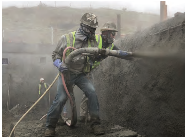
Fig. 2a La manguera es colocada en el suelo y sujeta por las piernas del lanzador. La manguera de la punta debe ser lo suficientemente rígida para continuar con su arco ascendente
