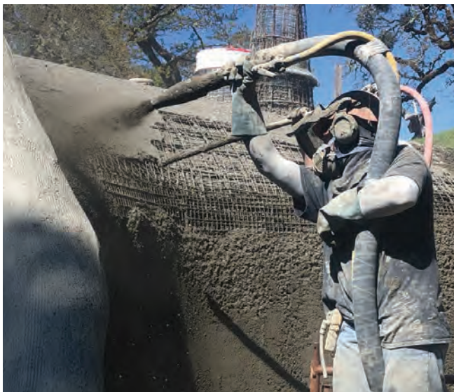
Fig. 2b Nota sujeción de la manguera de la punta con brazo
