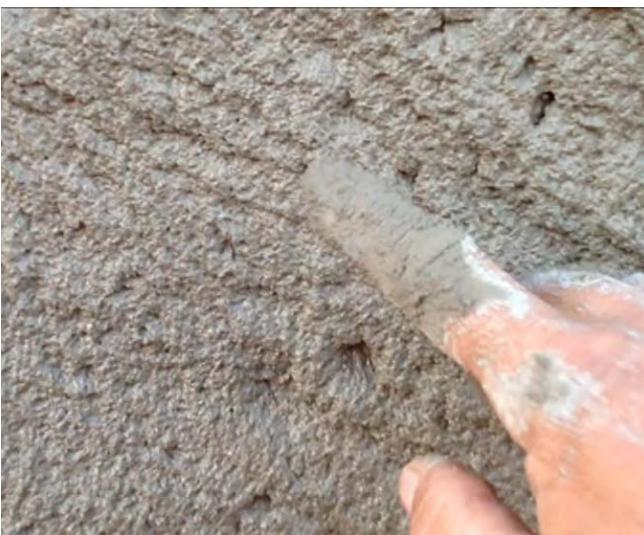
*Fig. 9: Los materiales recién aplicados con pocos agregados visibles en la superficie son el indicador visual de un revenimiento bien elegido.*
