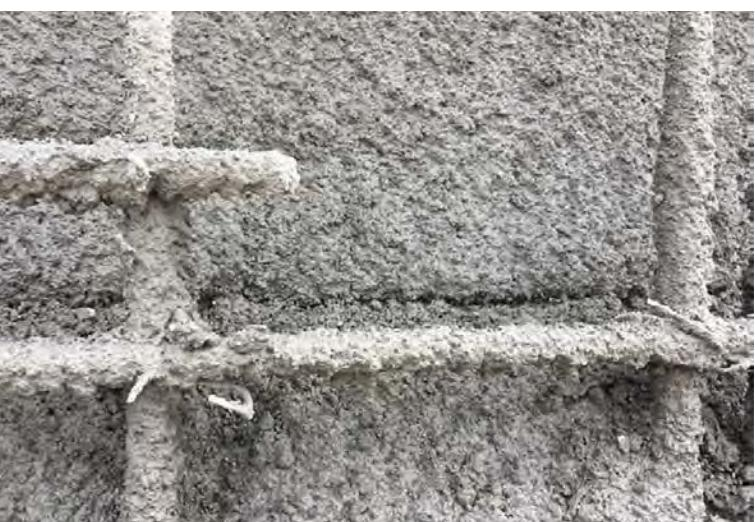
*Fig. 6a: El valle que ocurre dentro del área de sombra es fácil de ver. El valle detrás del refuerzo es evidencia visual de que la mezcla es demasiado rígida.*
