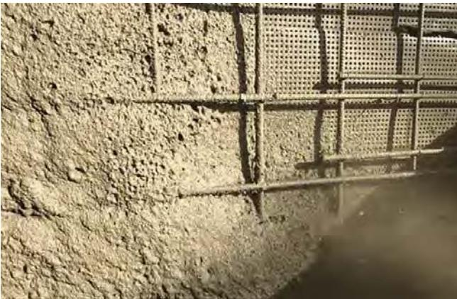
*Fig. 7: el revenimiento ideal permite que los agregados entrantes se incrusten profundamente dentro del mortero en lugar de permanecer en la superficie.*
