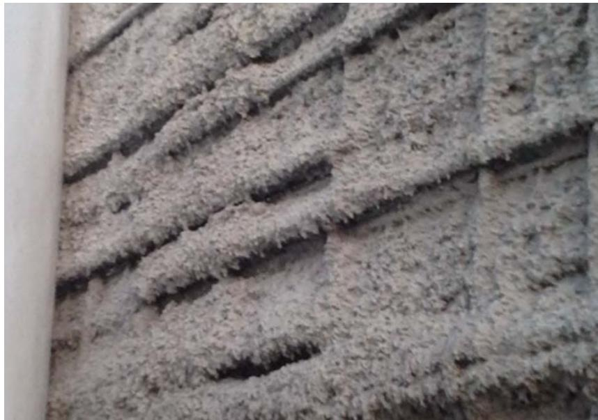
*Fig. 5: La evidencia visual de la acumulación de concreto en el refuerzo fue ignorada por el lanzador. Nótese los enormes vacíos que se han formado detrás del acero.*
