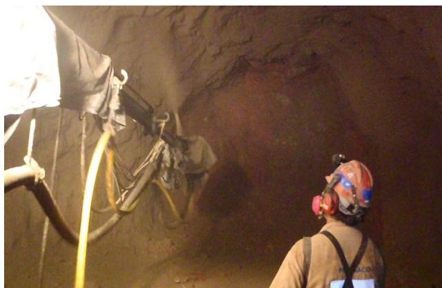
Fig. 2. Aplicación robótica de concreto lanzado
