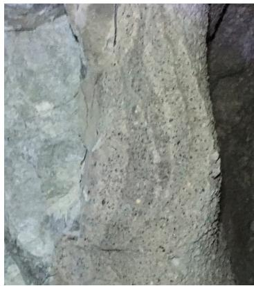
Fig. 4. Buna adherencia entre capas de concreto lanzado
