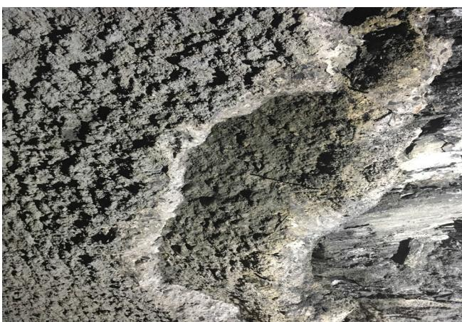
Fig. 3. La mala preparación de la superficie impidió la adhesión entre las capas de concreto lanzado y el concreto con la roca
