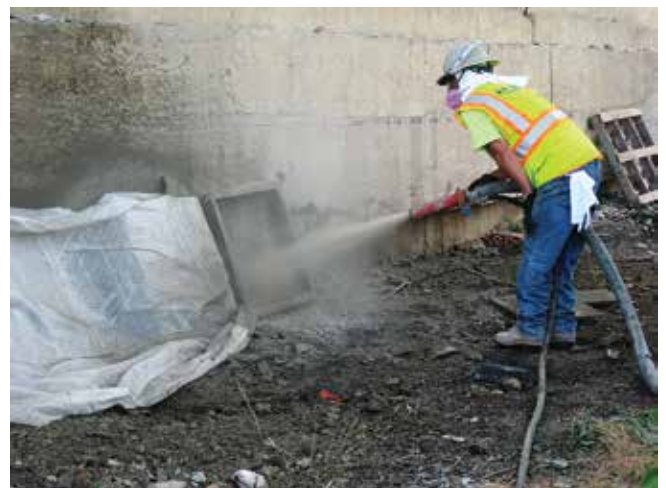
Fig. 1: Panel de prueba de campo debidamente colocado en el sitio
