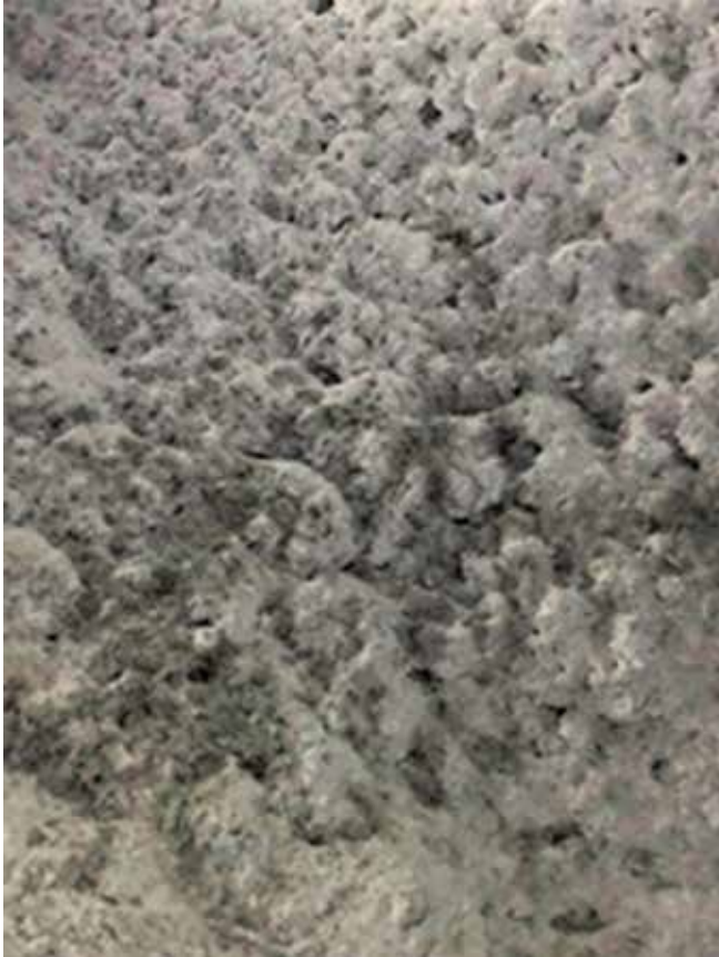
Fig. 3: La preparación adecuada de la superficie es vital para la aplicación exitosa del concreto lanzado
