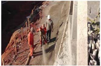
Fig. 5: Obviamente no lanzando ni siquiera cerca de 90 grados de la superficie receptora
