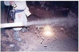
Fig. 4: El concreto lanzado es concreto lanzado acelerado neumáticamente a alta velocidad antes del impacto en la superficie receptora
