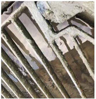
Fig. 1: Obviamente demasiada agua sobre el concreto en la tolva
