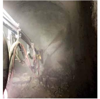
Fig. 2: Los aditivos juegan un papel importante en la producción de esta colocación subterránea de concreto lanzado
